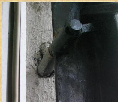
Альтернативой традиционным замкам является распашное устройство, которое размещается непосредственно в стене здания, что исключает возможность доступа к нему снаружи.
