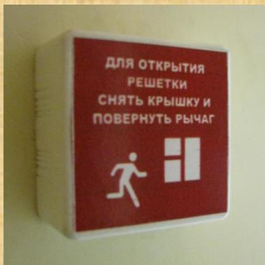
Для разблокирования решетки достаточно снять декоративную крышку и повернуть рычаг.
